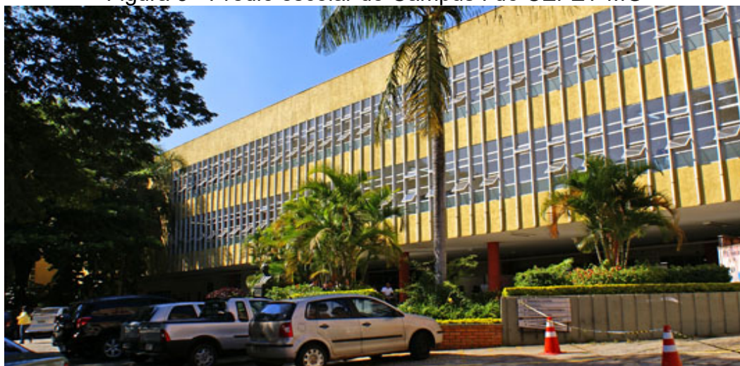
Figura 3 - Prédio escolar do Campus I do CEFET-MG
