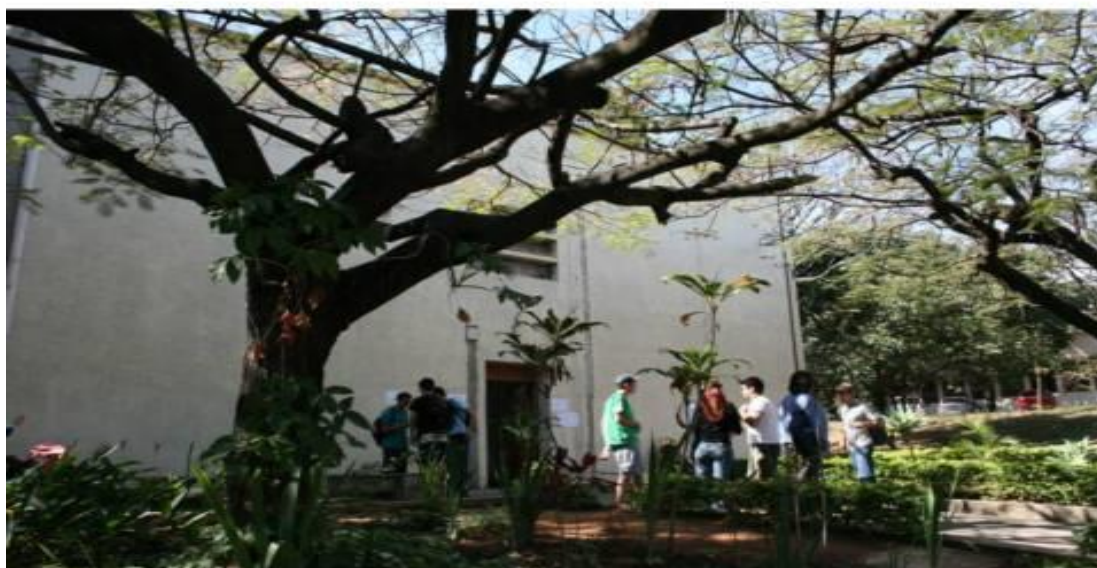
Figura 6 — Campus II , Prédio Principal - Fachada e entrada lateral
