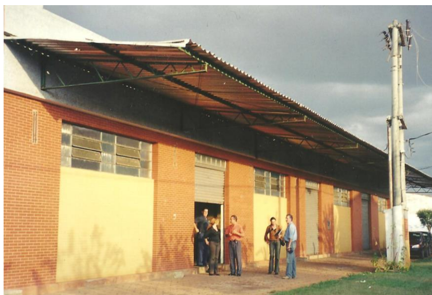
Figura 1 – Fotos Galpão Apare 10 2003 a 12 2015
