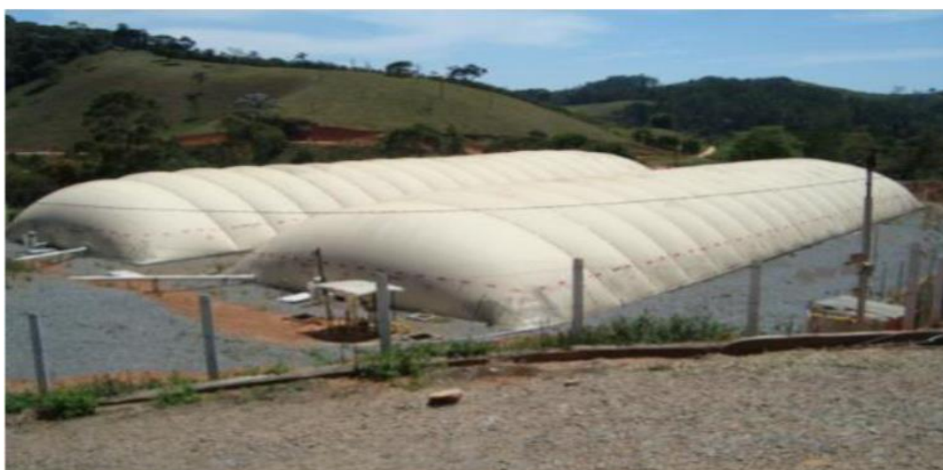
Figura 17 – Granja G3: biodigestores anaeróbicos
