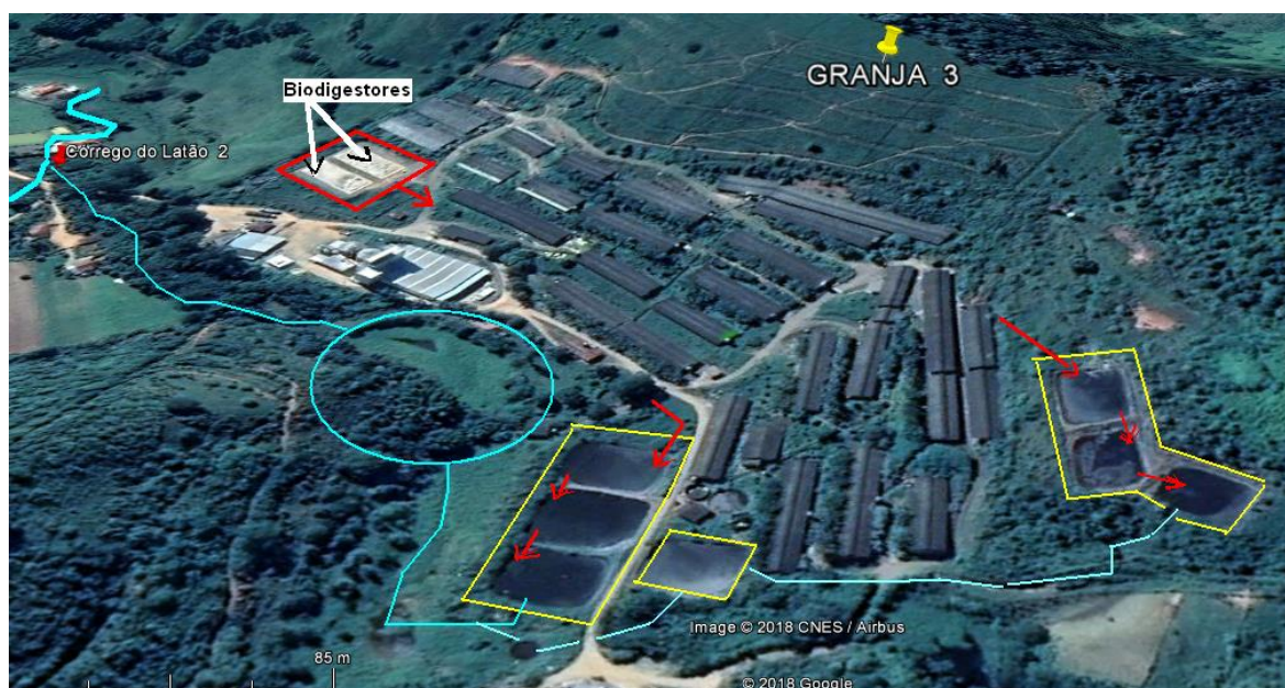
Figura 12 – Granja G3: sistema de tratamento dos dejetos
