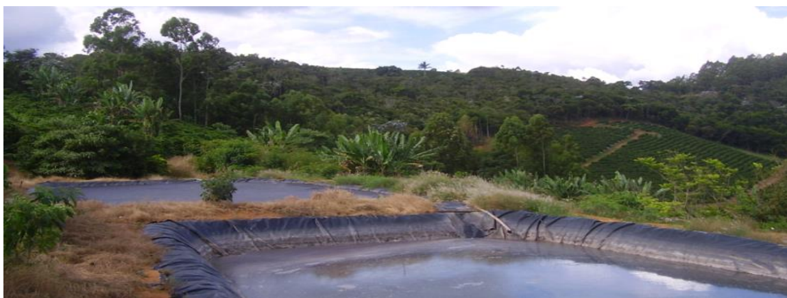
Figura 14 – Granja G2: tanques de decantação
